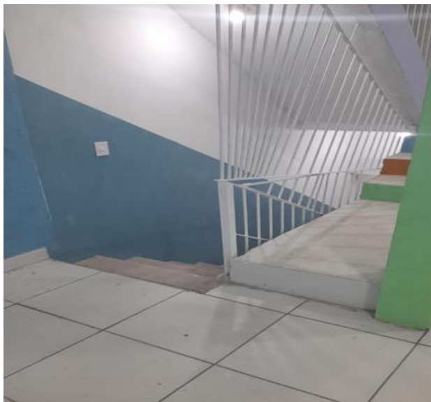
Acesso ao andar dos berçários II e maternais I
