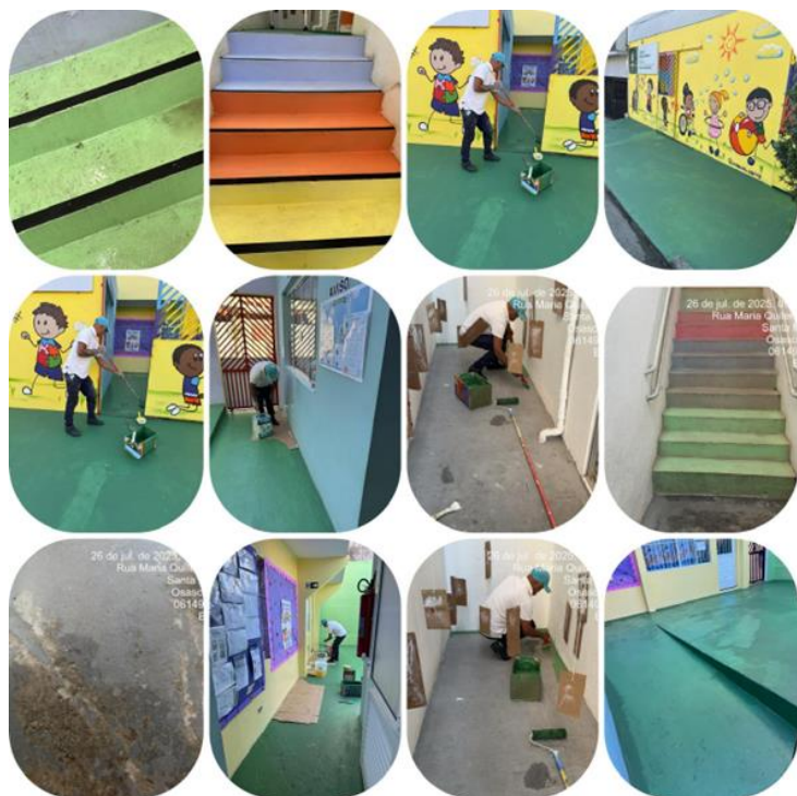
Pintura do parque e sinalização das escadas.
