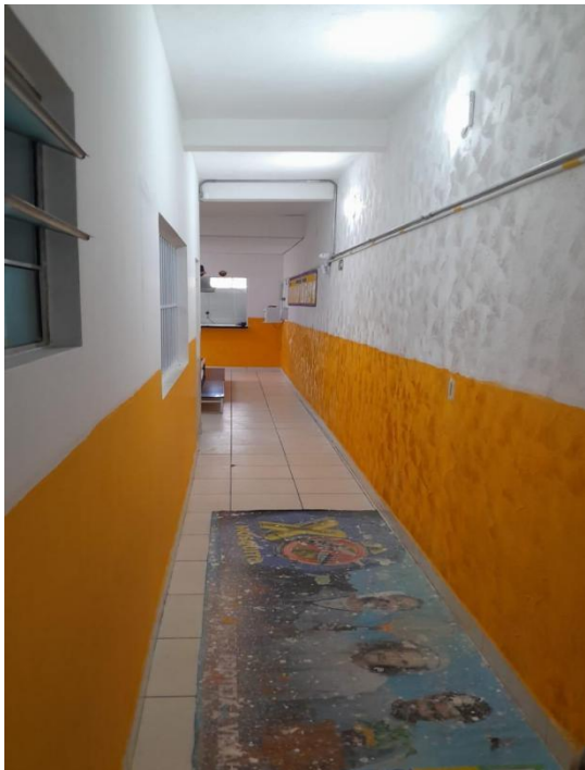
Pintura nova corredor e refeitório
