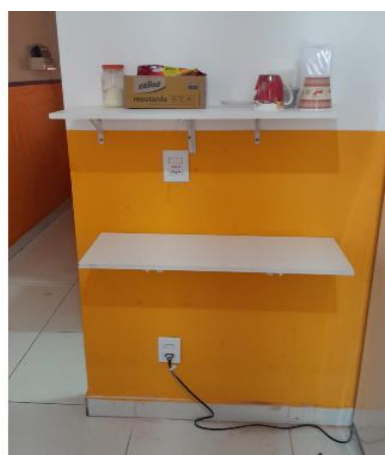
Instalação de tomada 220v
